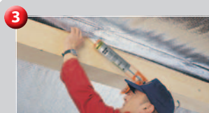
DELTA®-TIXX Colle en cartouche pour jonctions latérales. 310 ml par cartouche. Rendement : env. 7 m/cartouche.
