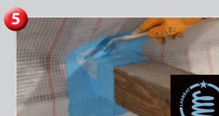
DELTA®-LIQUIX FX Résine solidifiante pour la mise en œuvre de l'étanchéité à l'air sur géométrie complexe et supports rugueux. Kit 400 ml (env. 0,4 m 2 ).
