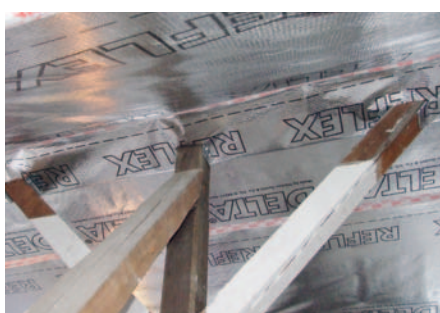
Rénovation en cours Pose du pare-vapeur DELTA®
