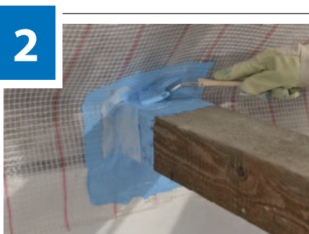
Rénovation en cours Pose du pare-vapeur DELTA®
