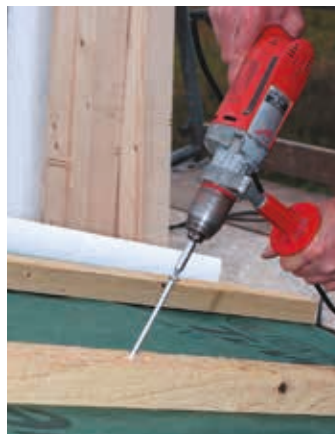
HECO-TOPIX®-Therm Befestigung der Konterlatten
