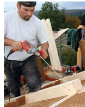
HECO-TOPIX®-CC Befestigung der Schubhölzer
